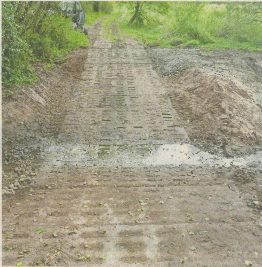
Im Naturschutzgebiet „Alte Meilschnitz“ wurde im Rahmen einer Bachrenaturierung die Verrohrung des Fließgewässers zurückgebaut. Stattdessen wurde eine Furt in den ehemaligen Kolonnenweg der DDR-Grenztruppen eingesenkt.
